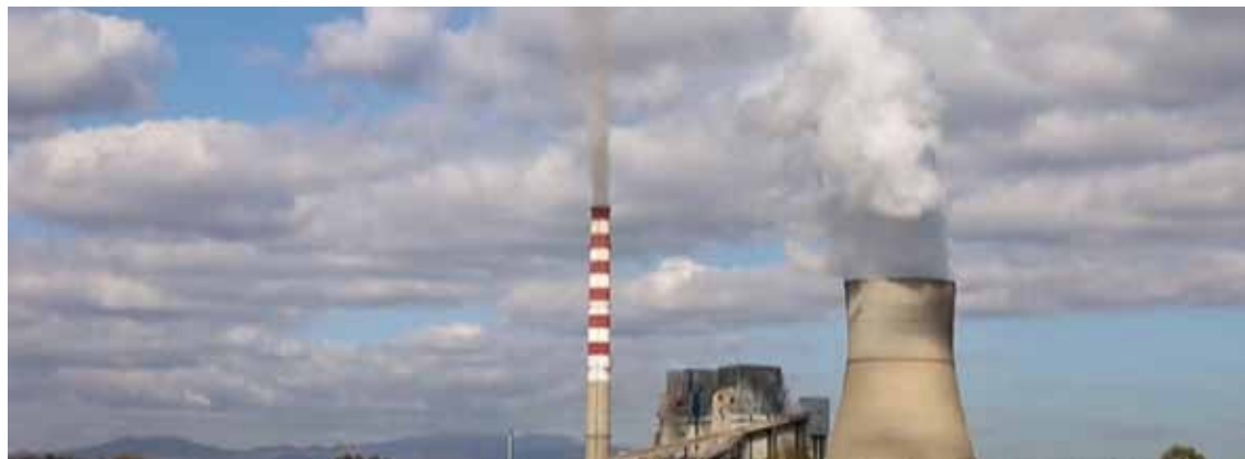
Figura 31. Ndotja nga Termocentrali i Obiliqit
